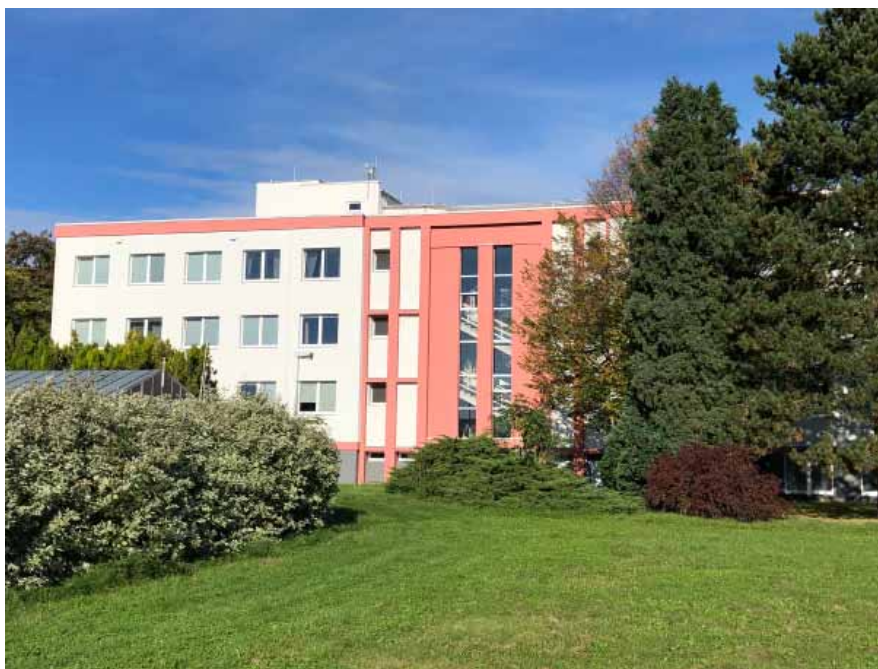
V roce 2020 prošla budova ústavu kompletní rekonstrukcí a instalací moderních technologií
