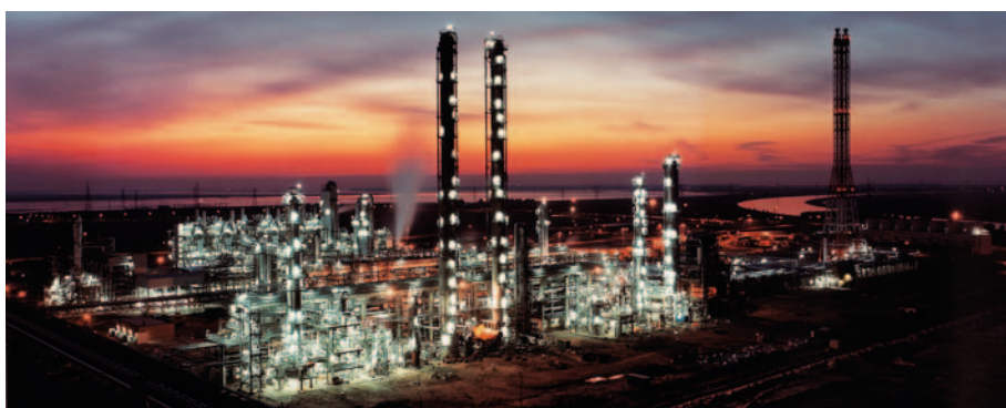
Parní štěpící jednotka (steam cracker) v novém Verbund závodě v Antverpách
