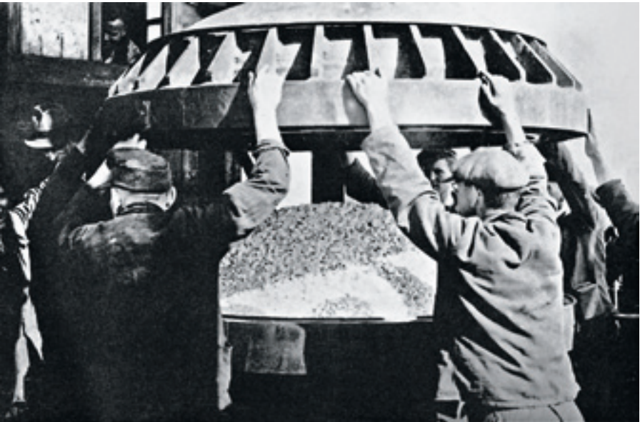
1941 V Ludwigshafene sa stavia tretí závod koncernu I.G. Farben na výrobu gumy podľa trojstupňového procesu, ktorý navrhol Walter Reppe. Spája továrne v Ludwigshafene a Oppau, ktoré boli až doteraz od seba vzdialené. Vľavo: Robotníci spúšťajú hlavu veže butynediolového reaktora v továrni na výrobu Buny.
