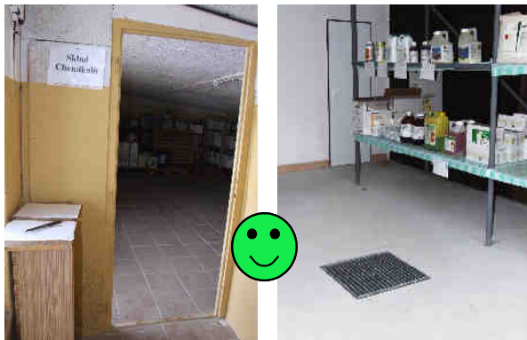
Obrázok 20: Priestor pre skladovanie prípravkov s hladkou, ľahko umývateľnou podlahou a odtokom do záchytnej nádrže (foto Kotleba, SCPA).
